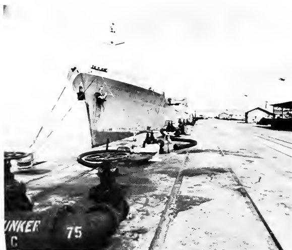
Un barco se abastece de combustible marítimo en el Muelle 16 de Cristóbal. En primer plano se ve un montacarga levadizo para petroleros que sirve para cargar y descargar combustible.
